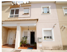
V4175 Dúplex Guadiana 97.00m 2 Hab: 3 Bñ: 2 Buen estado
